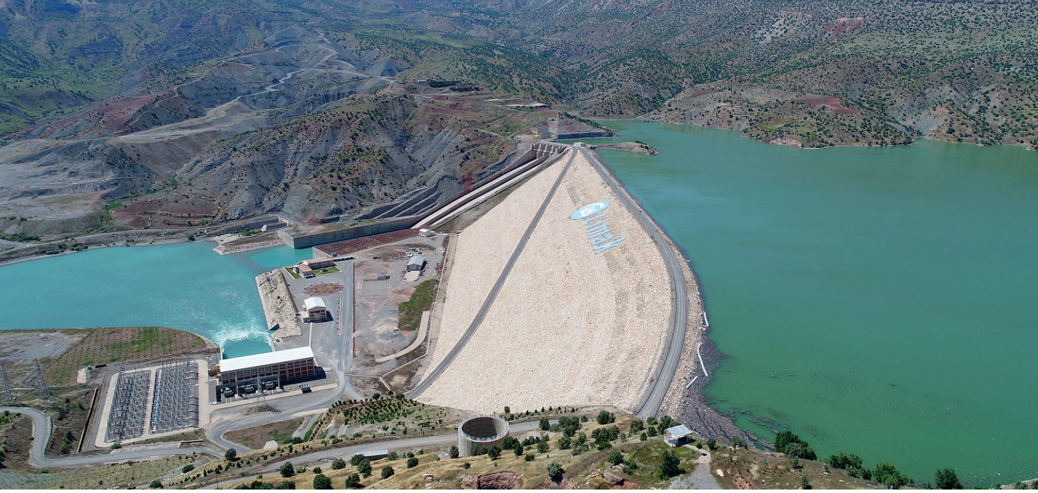
Alkumru Barajı ve HES
