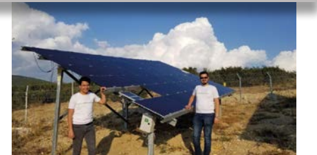
Demircioğlu Pilot Uygulaması Isparta Gönen Güneş Enerji Santrali
