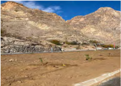
Yusufeli Barajı Yol İnşaatı Biyolojik Çeşitlilik, Erozyon Kontrolü ve Ağaçlandırma Projesi
